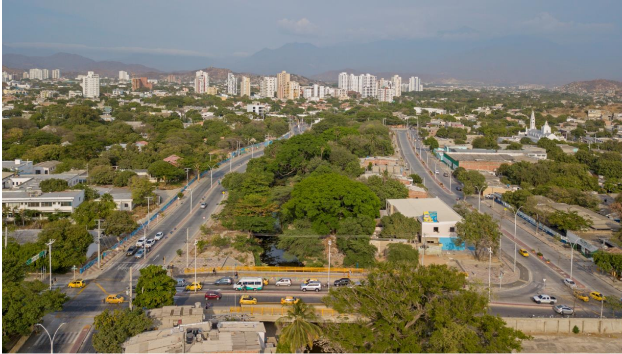
Figura 5. Puente Carrera 5 ta
