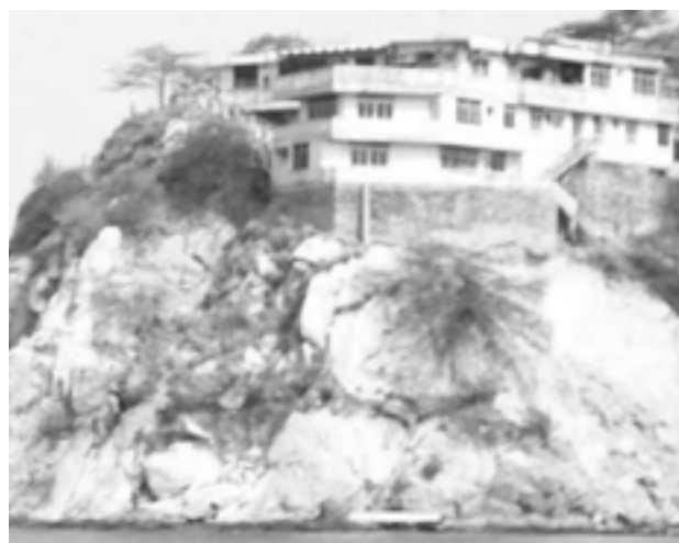
Únicas ruinas del Fuerte de Betín. En la foto se evidencia el amurallamiento del lugar, para lograr la explanada, con el uso de piedras lajas del mismo cerro, y ladrillo cocido
