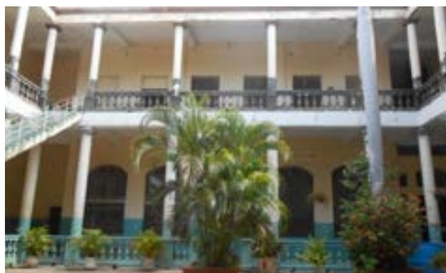
Fachada de la I.E.D. Industrial. Fotografía: Paola Larios Giraldo.
